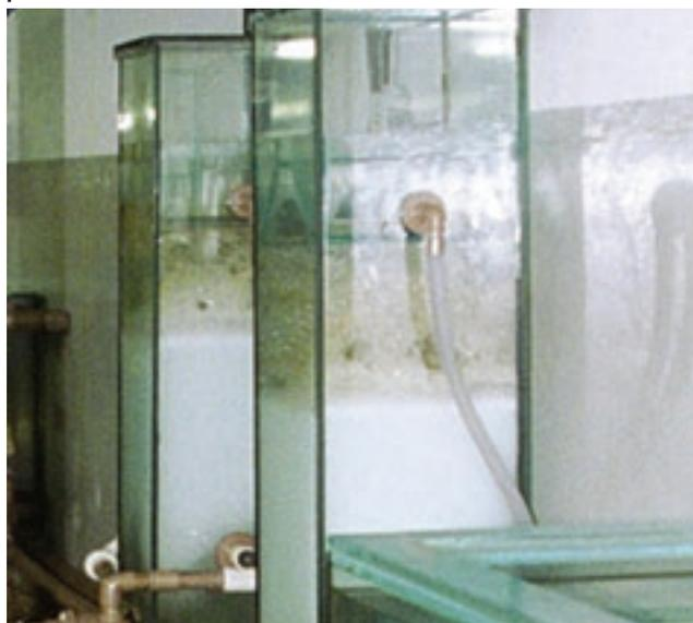
Системы фильтрации и водоочистки – в основном самодельные (как, например, эти колонки, заполненные несколькими слоями адсорбентов), но эффективные и сделанные с умом
